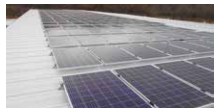
▲新「新城センター」に設置した太陽光パネル
