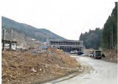
建設中の新工場。
