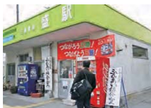
被災した三陸鉄道盛駅舎を使った「ふれあい待合室」。
